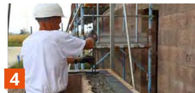
2 Svi naredni redovi se postavljaju bez cementa, na suvo
